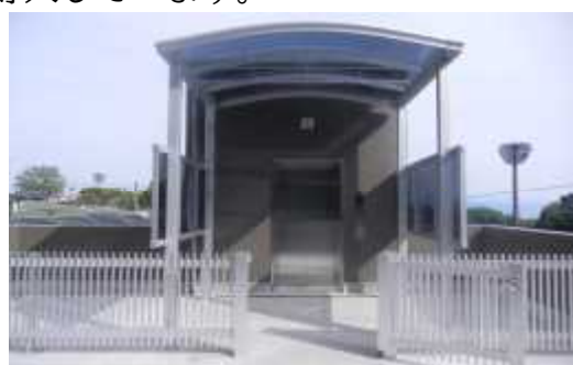
あしたか球場 エレベーターの整備
