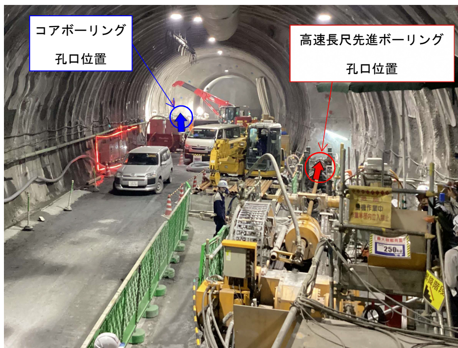
図 1 高速長尺先進ボーリングとコアボーリングの実施状況
