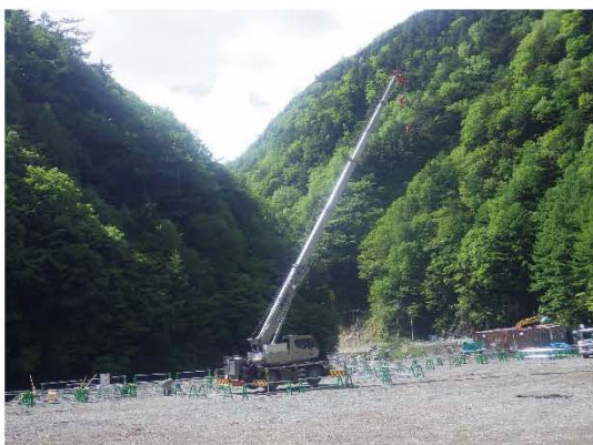
クレーン設置状況
