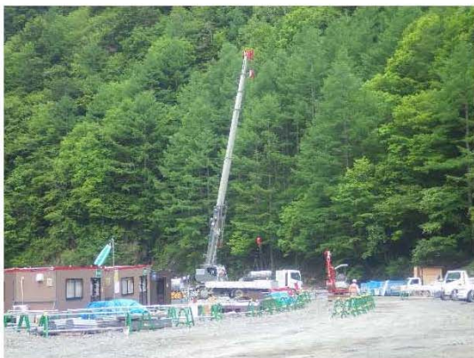
クレーン作業状況
