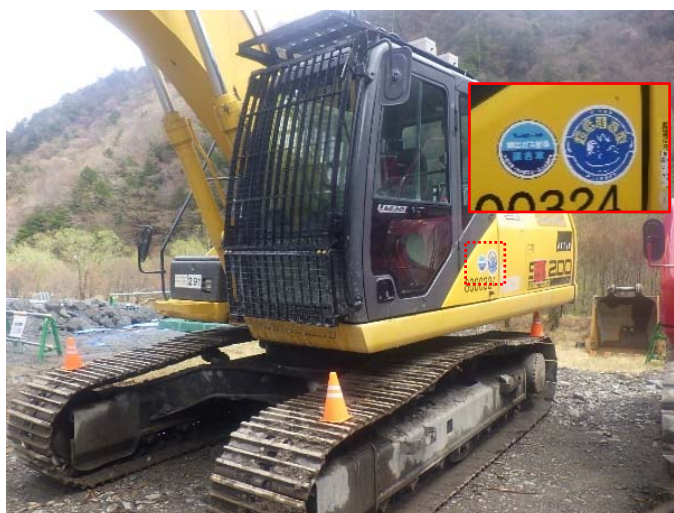
図 4.26 排出ガス対策型、低騒音型建設機械の使用状況
