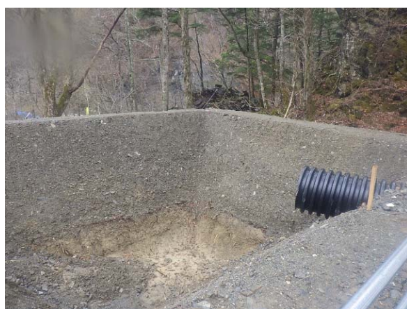
図 4.25 仮設沈砂池（左）、高度浄化装置（右）の設置状況
