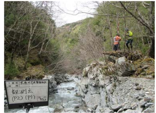
図 4.38 現地試験状況（魚無沢）
