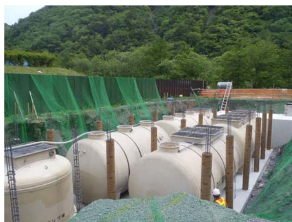
図 4.25 仮設沈砂池（左）、高度浄化装置（右）の設置状況
