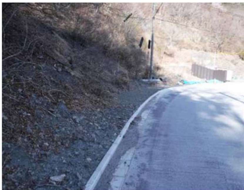
図 4.29 林道東俣線における舗装状況
