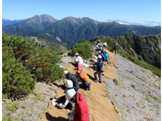
<南アルプスの自然> 塩見岳山頂付近(標高約3000m)での植生マット敷設
