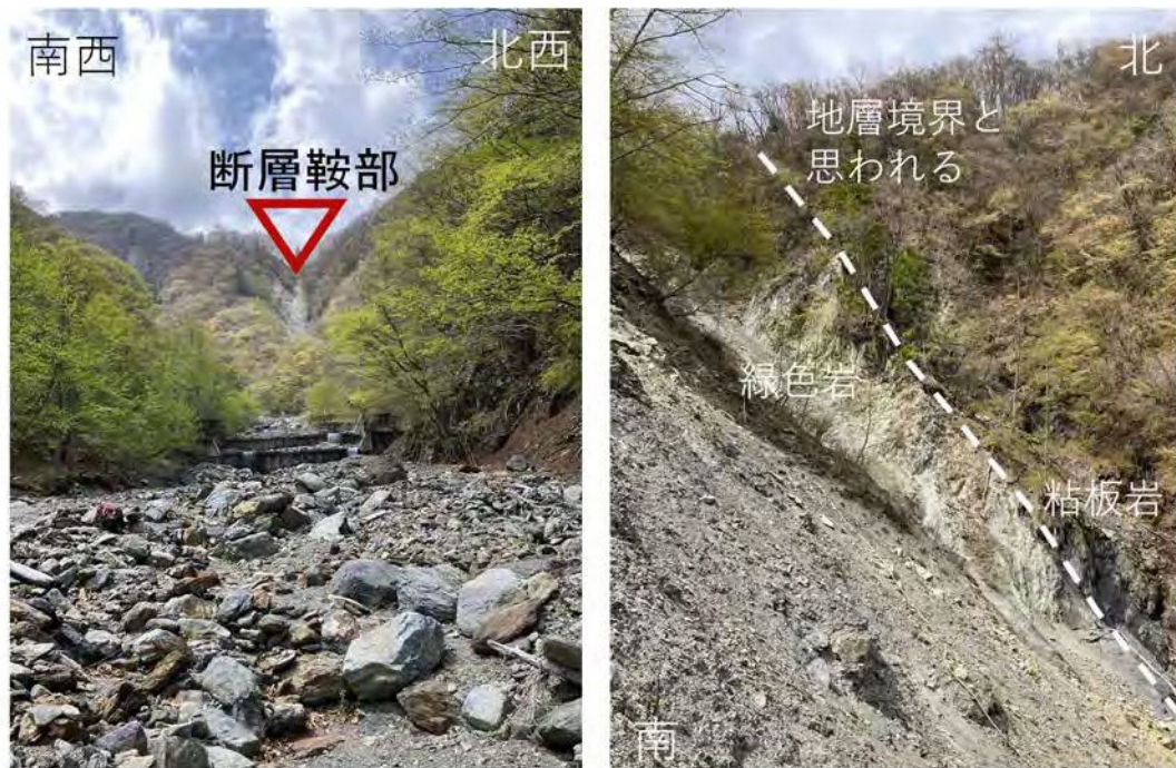
写真 2 調査 2 地点断層鞍部遠望と露頭状況
