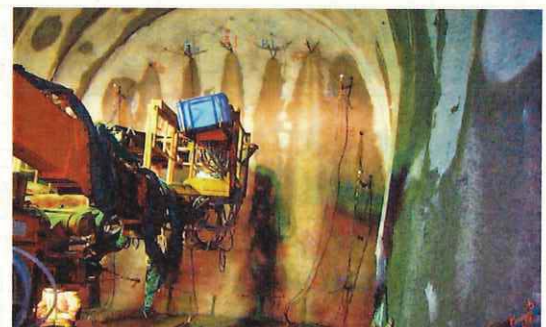
写真 薬液注入工の施工例
