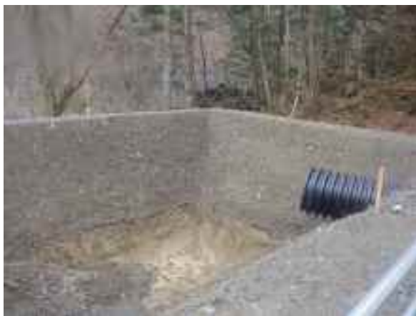
図 4.73 仮設沈砂池（左）、高度浄化装置（右）の設置状況
