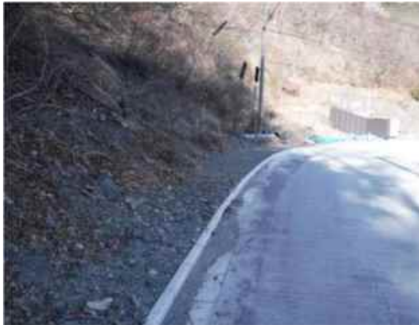
図 4.78 林道東俣線における舗装状況
