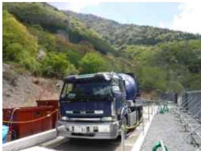
図 4.76 タイヤ洗浄の実施状況
