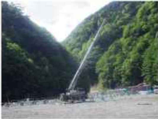
クレーン設置状況
