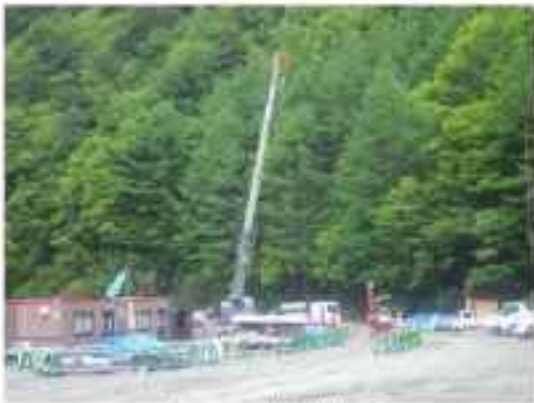
クレーン作業状況
