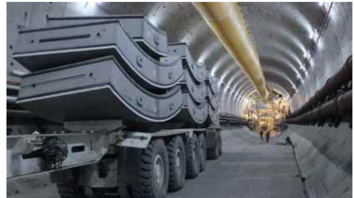
図 4.40 RCライナーの施工状況写真例
