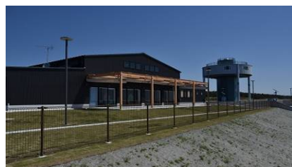
福田漁港 磐田市渚の交流館と 津波避難タワー (磐田市)
