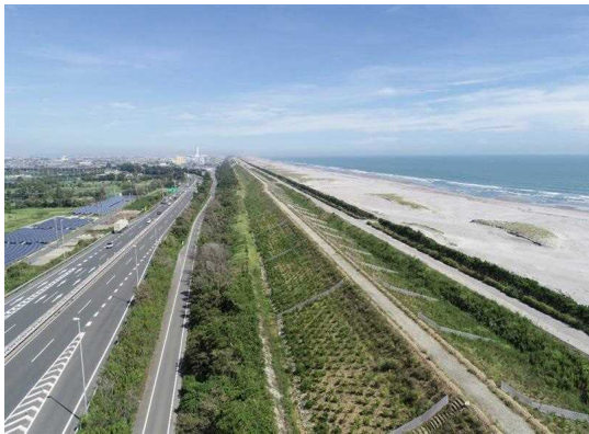
遠州灘に沿って整備された防潮堤（浜松市）
